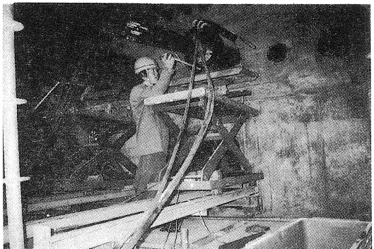
写真-3 2次ケーブル緊張状況
