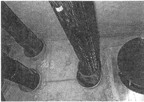
写真-2 外ケーブル偏向部構造
