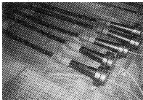
写真-4 PC鋼材挿入前
