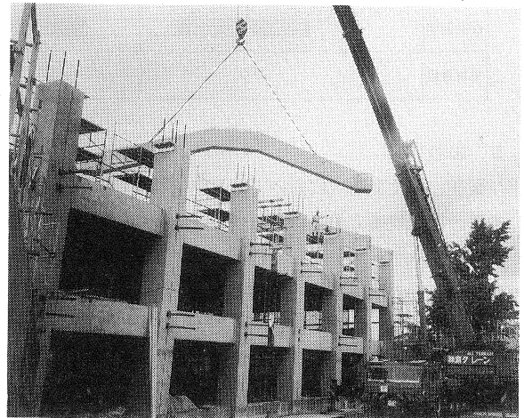
写真-2 現場の部材架設
