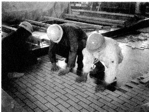
写真-4 タイルユニットの固定状況
