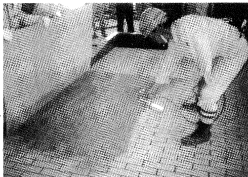
写真-5 接着剤の塗布状況
