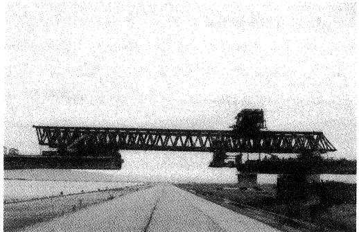
写真-2 逆張出し架設
