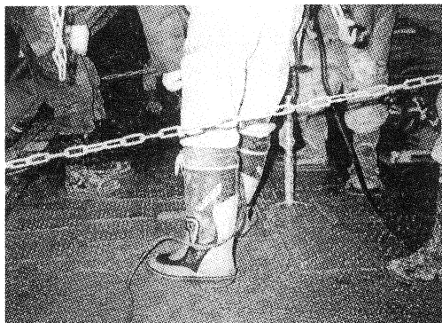
写真-3 表面仕上げ用バイブレータ使用状況
