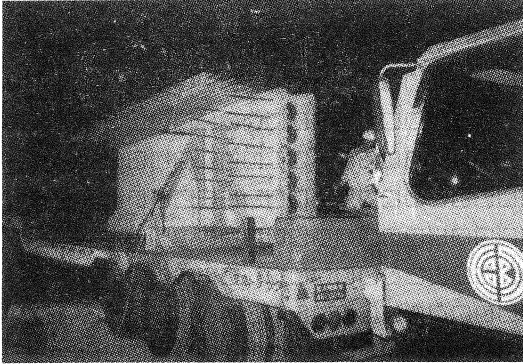
写真 1 主桁運搬状況
