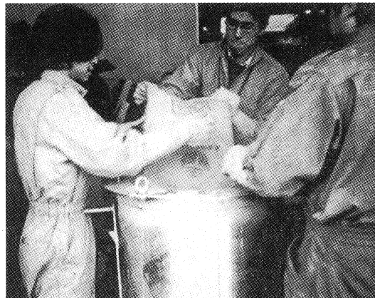
写真-3 結合材の投入状況
