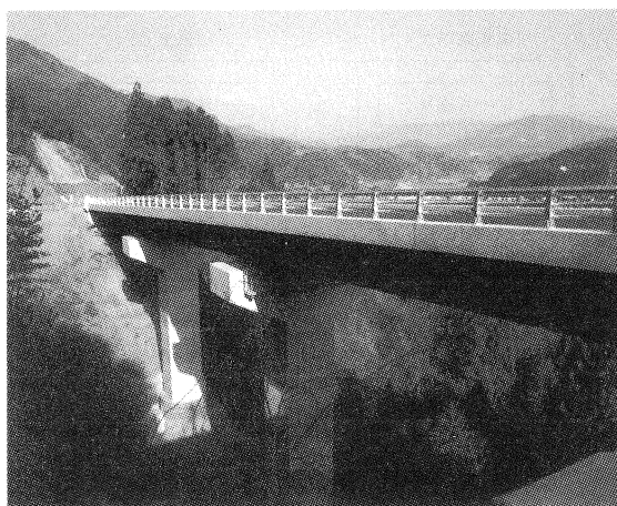
写真-4 完成写真 (全景)
