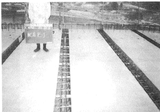
写真-2 継手部配筋完了
