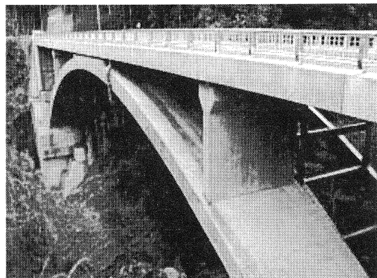
写真-2 橋梁全景 (完成)
