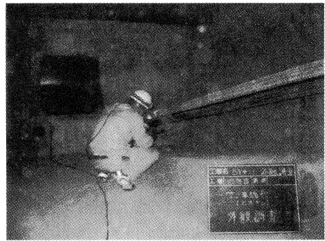
写真-3 外観調査状況(下り線)
