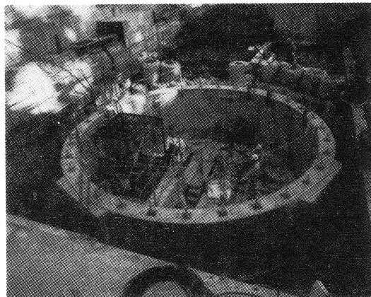
写真-4 セグメント設置完了状況
