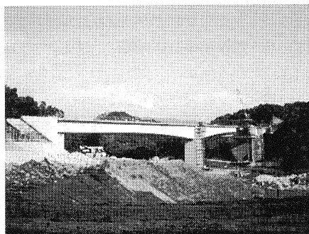
写真-3 施工状況 (平成15年6月現在)
