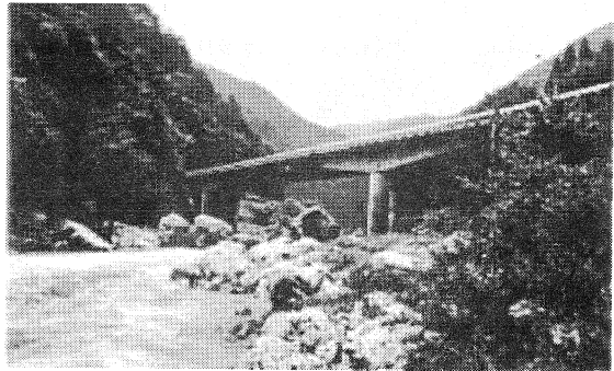
写真-1 旧不動橋全景
