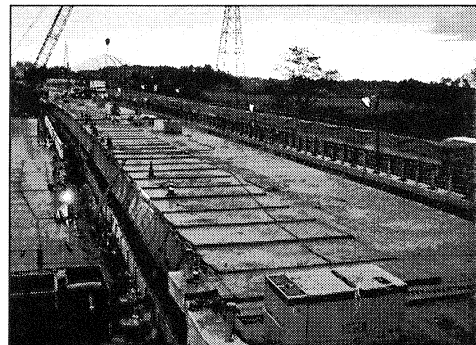
写真-2 既設床版の仮置、撤去状況
