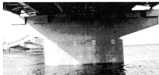
写真-3 完成後 (P1 橋脚)
