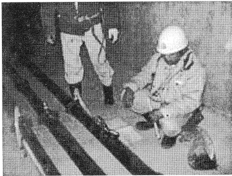
写真-5 中間圧力確認状況
