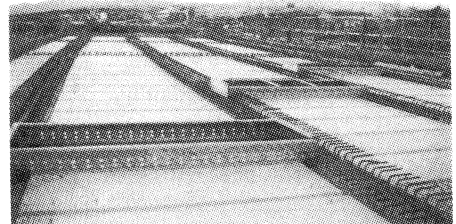
写真-4 PC板設置完了全景
