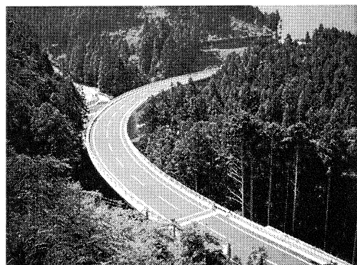
写真-2 完成写真
