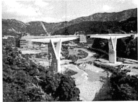
写真-3 張出施工
