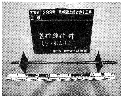
写真-4 型枠締付材
