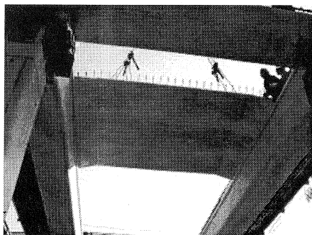
写真-6 中間スラブ部材架設状況
