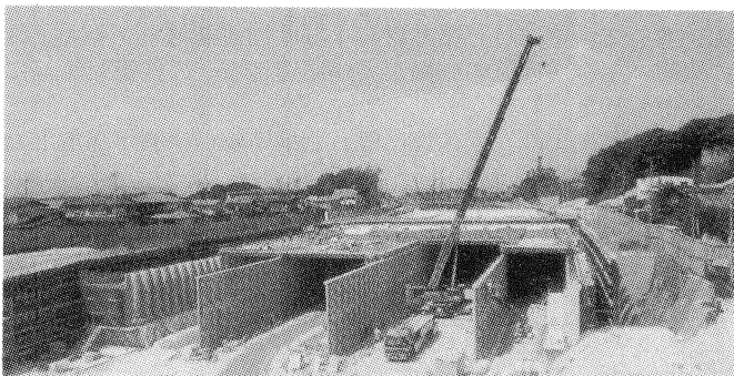
写真-1 架設状況
