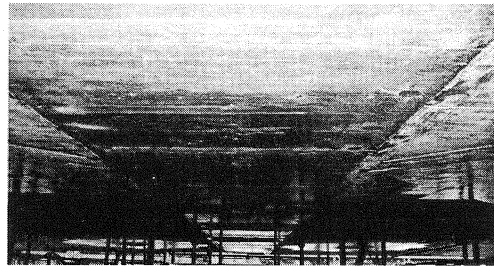
写真-2 ヒンジ間詰め部コンクリート打設前と連続化完了後
