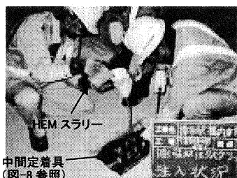
図-11 中間定着具の設置と HEM スラリーの注入状況
