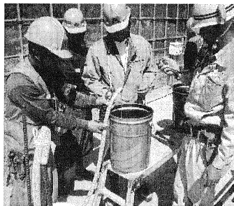
写真-4 排気口からの排出確認
