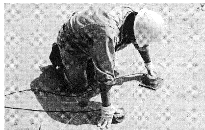
写真-6 非破壊検査状況 (広帯域超音波による超音波探傷法)
