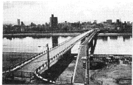
写真-1. 完成全景
