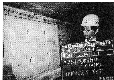
写真-4 削孔完了
