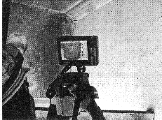
写真-5 赤外線探査状況
