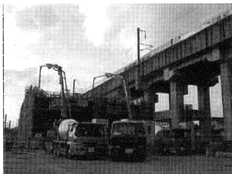
写真-1 コンクリート打設全景
