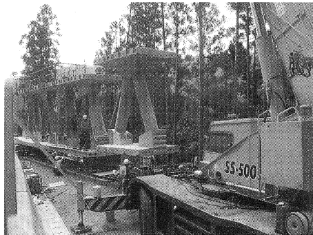
写真-3 セグメント接合状況
