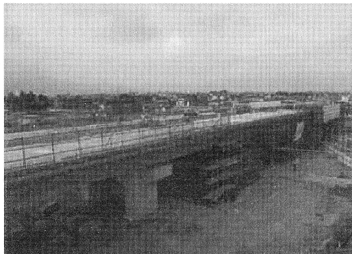
写真-8 施工状況全景 (5月下旬)
