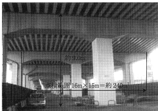
写真-2 試点検を行ったS2橋の現地状況
