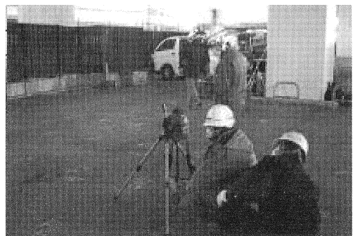
写真-1 点検作業状況
