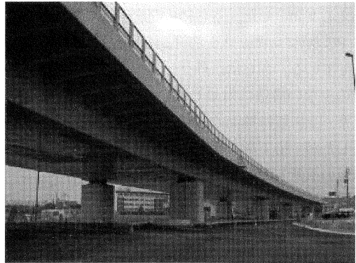
写真-1 常滑高架橋
