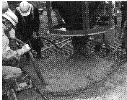
写真-4 超高強度コンクリート打設状況
