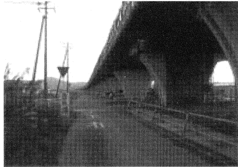
写真-5 上部工施工状況
