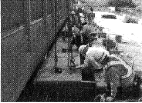
写真-3 プレキャスト張出し床版 架設状況
