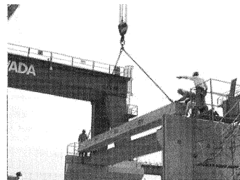
写真-2 組立試験
