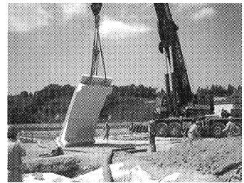
写真-3 側面壁の建直し
