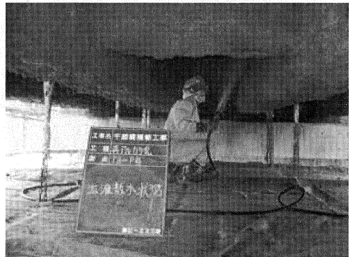
写真-5 散水状況
