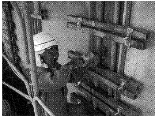
写真-6 2次コンクリート型枠組立状況
