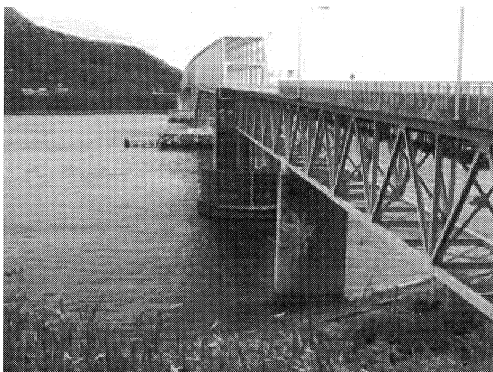
写真-2 P1・P2橋脚
