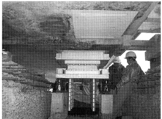
写真-4 新支承設置状況
