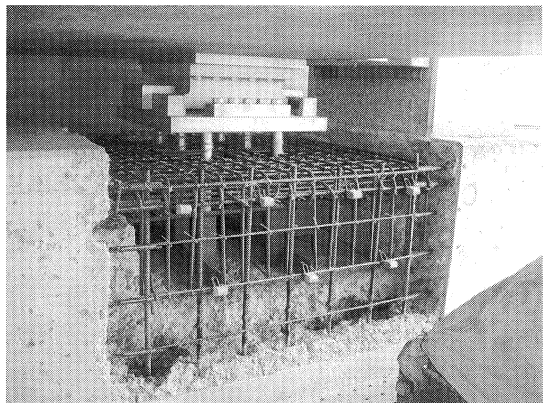
写真-5 鉄筋組立状況
