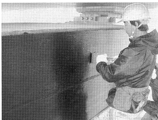
写真-7 シート工施工状況
