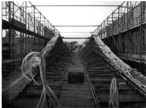
写真-4 養生状況
