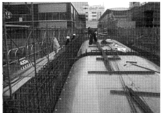
写真-2 型枠・鉄筋組立て工
