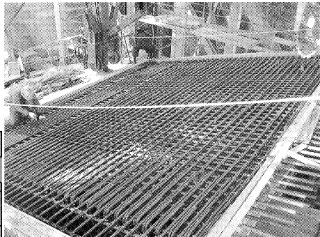
写真-3 上床版の鉄筋組立て
