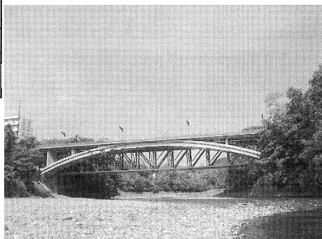
写真-4 万年橋全景
