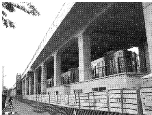
写真-3 ラーメン躯体施工完了状況
