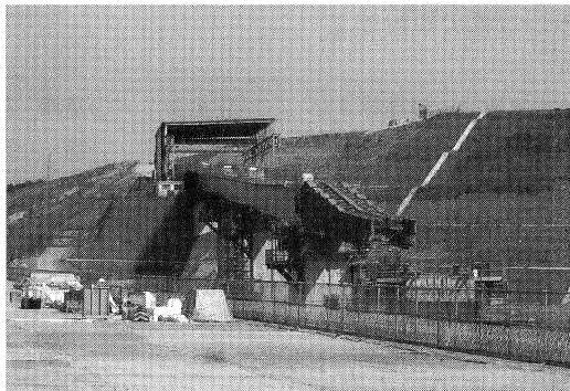
写真-2 押出し状況
