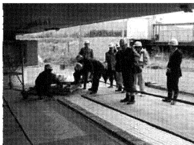
写真-6 アウトプレート設置状況
