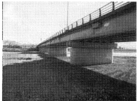
写真-1 橋梁全景
