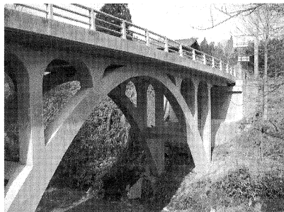
写真-8 橋梁本体補修完了状況
