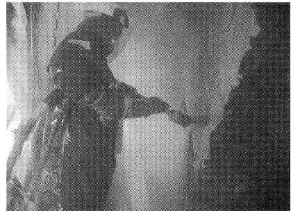
写真-4 はつり状況
