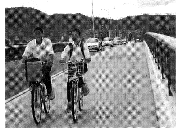
写真-8 拡幅後の歩道
