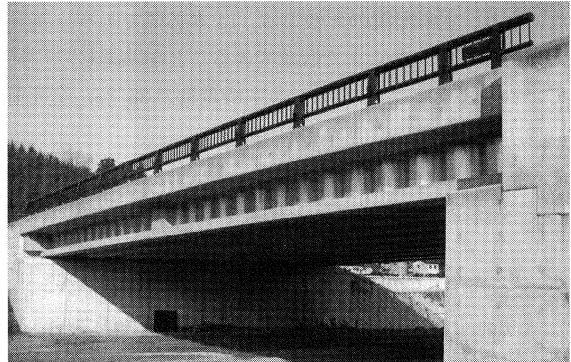
写真-1 曾宇川橋全景
