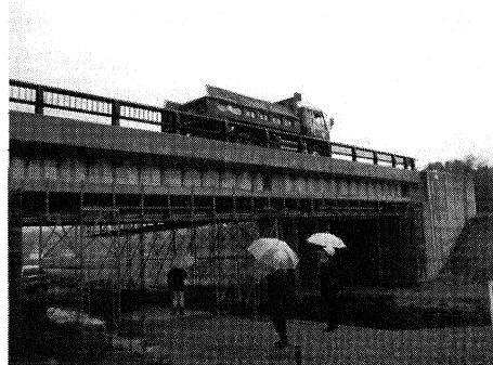
写真-4 実橋載荷試験状況
